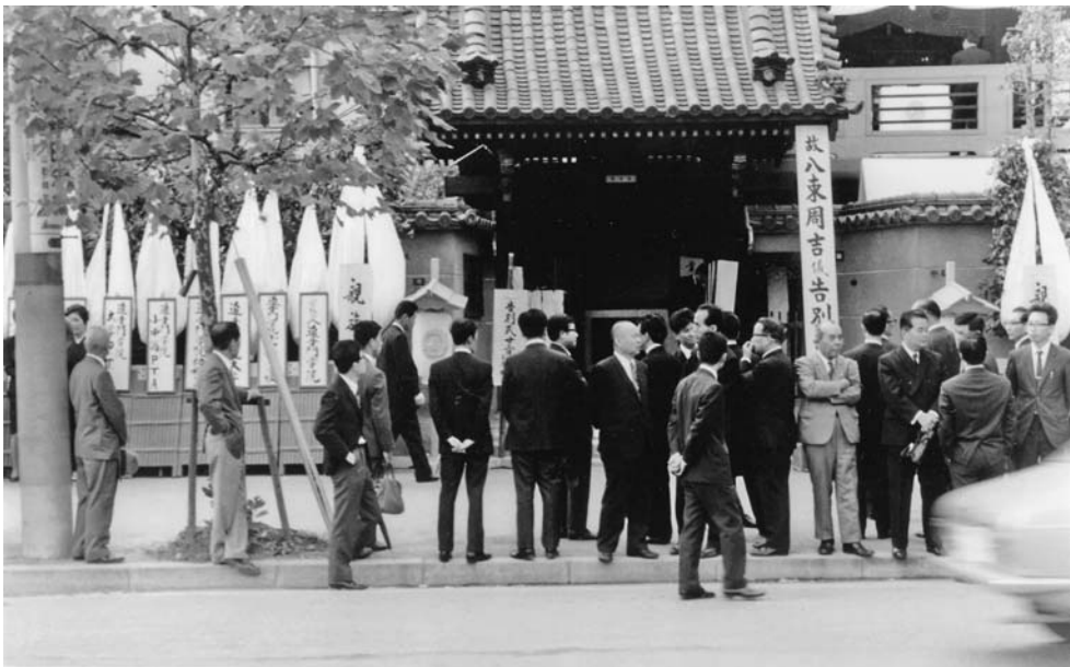
写真① 「欣浄寺」（現、谷町1丁目）故八束先生を偲ぶ参列者（多くは学院関係者と思われる）〔撮影者不詳〕
