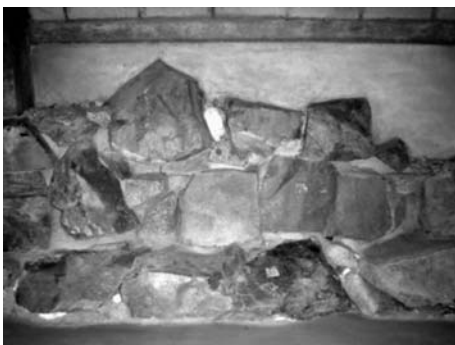
東館地下ホールの保存石垣
