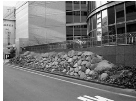
ドーンセンター北側
