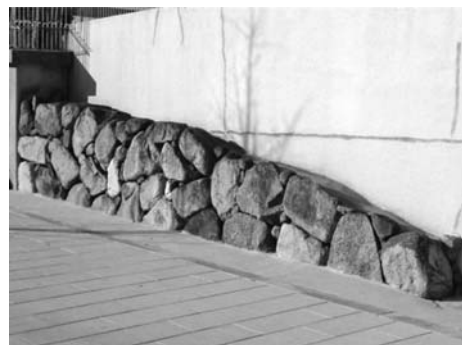
東門横に移設した石垣
